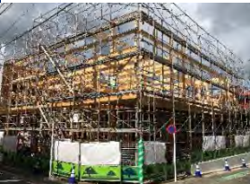
<梅丘建設中の新園舎>
