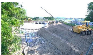
<樋門工事の様子 平成 30.5.15 現在>
